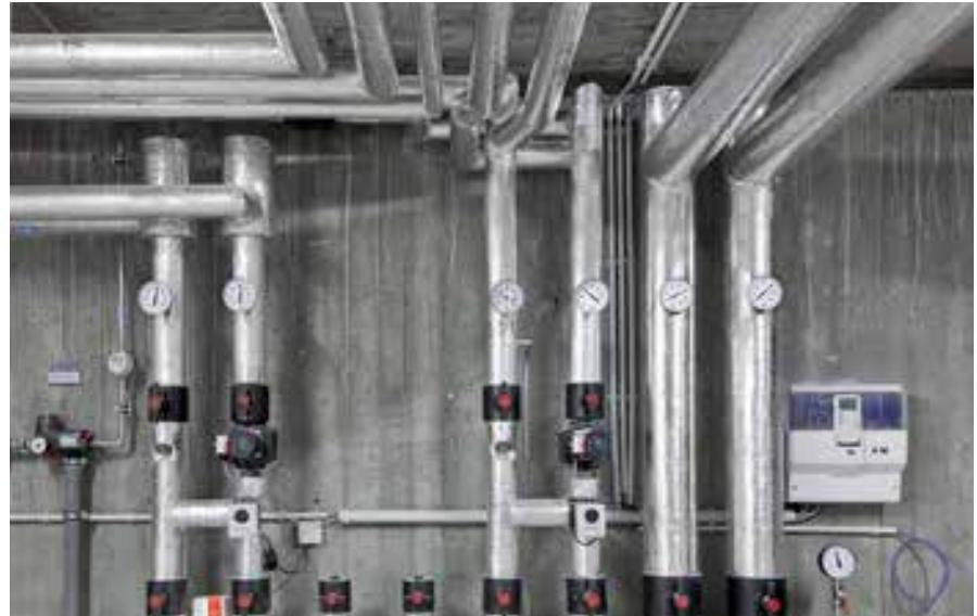
Das Isolieren von Heizungsrohren spart einiges an Heizenergie ein. Die Kosten der Rohrisolierung haben sich schnell gerechnet. Aber auch Kaltwasserrohre profitieren von einer Isolierung. Hier werden Fließgeräusche reduziert und Schwitzwasser verhindert. Eine Rohrisolierung lohnt sich also in jedem Fall.
