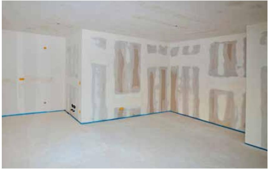
Brauchst du schnell ein neues Zimmer? Vorhandene Wohnflächen lassen sich mit einer Ständerwand einfach unterteilen und der Wohnraum an den geänderten Bedarf anpassen. Mit Metallprofilen hast du den Vorteil, dass diese mit einer Menge Systemteilen erhältlich sind und damit jede denkbare Wand schnell und einfach gebaut werden kann.
