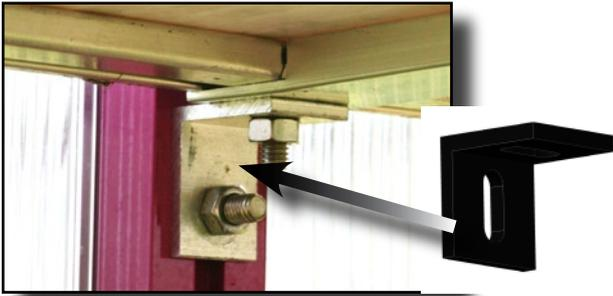
Anschließend werden die Abstandshalter zusammen mit dem Querprofil (Pos. 2) und den Auflagewinkeln (V185) am Längsprofil verschraubt.
