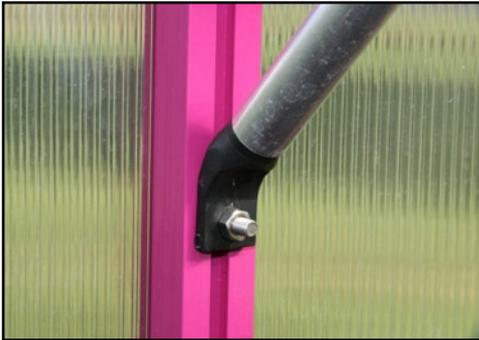
Tisch/Borte an den Gewächshaus-sprossen verschrauben. Hierzu die Streben (Pos. 3) und die Winkel (V185) an den Sprossen mit Hilfe der Hammerkopfschrauben M6 x 16 (S15) anschrauben.
