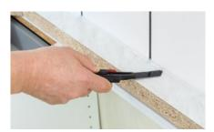
**1.** Altes Silikon entfernen und die Fugen mit Silikonentferner gründlich reinigen. Silikonanhaftungen, auch auf den Fliesen, müssen restlos beseitigt werden, um Haftungsprobleme zu vermeiden.
