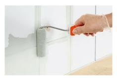
2. Sofort mit einer Walze den Lack dünn auftragen und abwechselnd in Längsund Querrichtung gleichmäßig verteilen.
