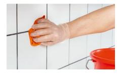
2. Fliesenoberfläche mit Alpina Bad & Küche Fliesen- & Fugen-Reiniger reinigen. Gründlich mit klarem Wasser nachspülen und Oberfläche vollständig trocknen lassen.
