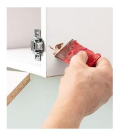
**4.** Löcher und beschädigte Stellen z.B. mit **Clou Holzpaste** ausbessern und anschließend glatt schleifen.
