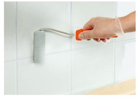
**3.** Zum Schluss wird die Oberfläche mit der Walze in eine Richtung durchgerollt, um eine möglichst gleichmäßige Oberfläche zu erhalten.
