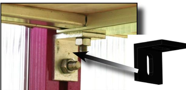
Anschließend werden die Abstandshalter zusammen mit den Streben (Pos. 3) und den Auflagewinkeln (V185) am Längsprofil verschraubt.
