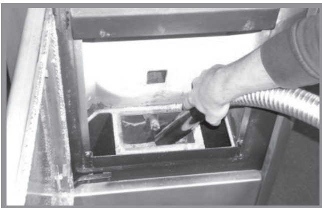
Abb. 12e: Reinigung Brennraumbehälter
