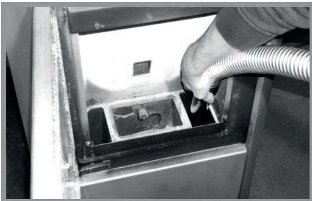
Abb. 12f: Reinigung untere Brennkammer
