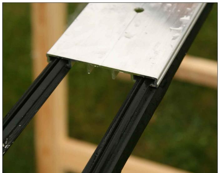
Dichtgummi in die Aluprofile einziehen.
