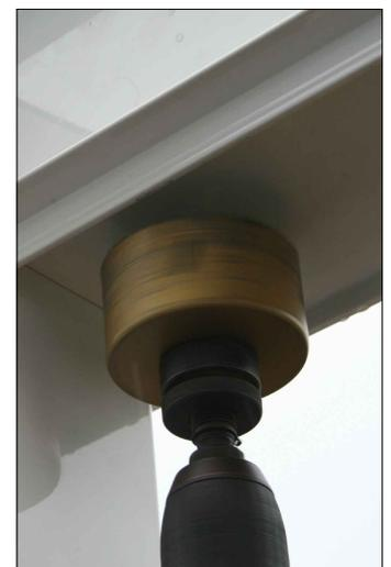
Mit einer Bohrkronen (Durchmesser 68-70mm) bohren Sie jetzt den Anschluß für das Fallrohr. Es kann sowohl neben als auch im Pfosten verbaut werden. **Bitte beachten Sie dabei den Versatz in der Rinnenpfette (siehe Detailzeichnung) sowie den Abstand der Clipphalter für das Fallrohr zum Pfosten ! (ca. 2cm)**
