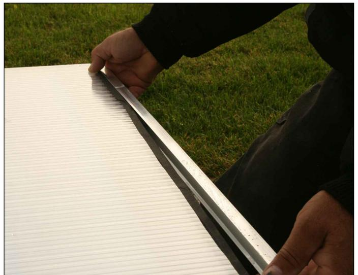
Das Abschlußprofil an der Vorder- und Hinterkante der Platten über das Dichtband schieben.
