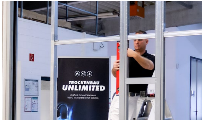
Bild 31: Meterriss im Taschenprofil prüfen
