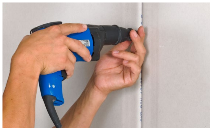
Bild 54: Entfernen der Montagehilfen
