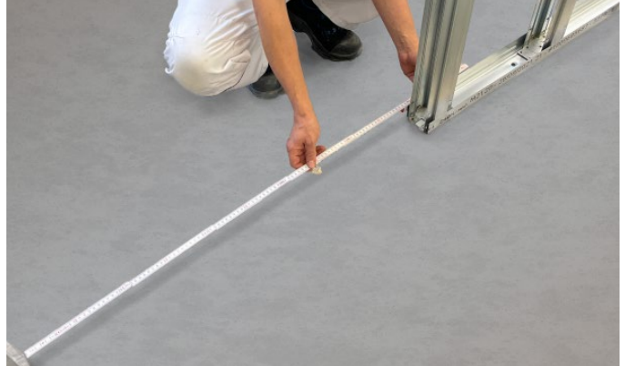
Bild 30: Ständerprofile ausrichten
