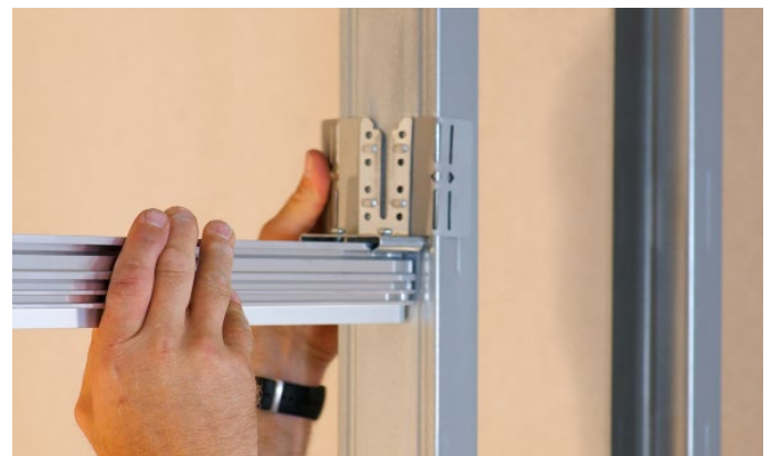
Bild 28: Sicherungslaschen umklappen
