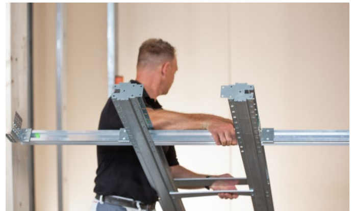
Bild 27: Ausrichten Pocket Kit Easy
