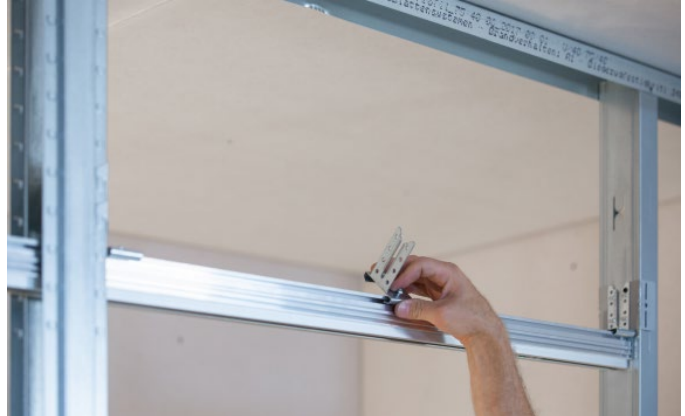
Bild 47: Montage in der Vorsatzschale
