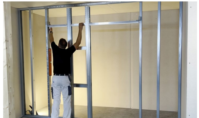
Bild 28: Sicherungslaschen umklappen
