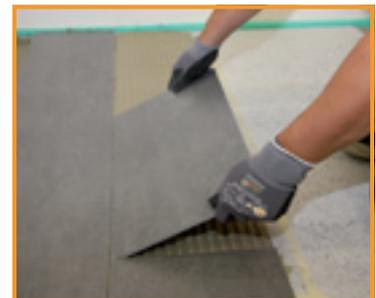
**9** Nach Begehbarkeit (siehe Produktinformation des verwendeten Racofix® Fliesenklebers) kann die Verlegung von Fliesen und Platten auf der Racofix® Entkopplungs- Dämmplatte erfolgen.
