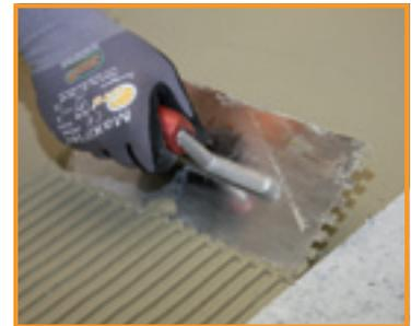
**6** Mit der glatten Seite der Kelle zunächst unter Druck eine Kontaktschicht, anschließend mit der Zahnung (6-8 mm) einen flexiblen Racofix® Fliesenkleber (Racofix® Multi-Flexkleber oder Racofix® Super-Flexkleber S1) aufziehen.
