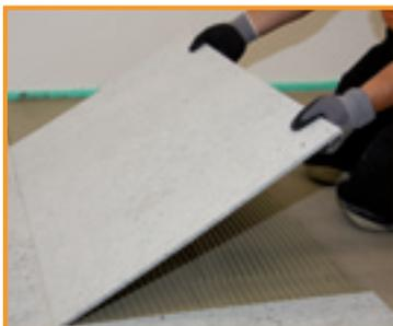
**7** Racofix® Entkopplungs- und Dämmplatte in das frische Kleberbett einlegen und gut andrücken. Die Verlegung erfolgt Stoß ab Stoß.
