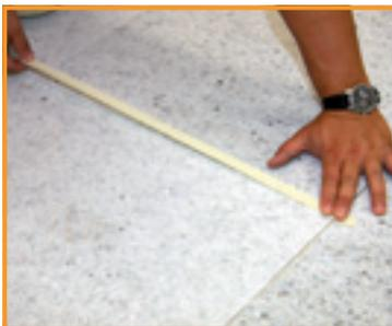
**8** Stöße nebeneinander liegender Platten werden versetzt verlegt, Stoßbereiche mit Klebeband (Tesakrepp) überkleben.
