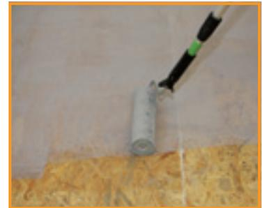
**3** Racofix® Spezial-Haftgrund mittels Rolle auf den Holzuntergrund aufbringen. Die Grundierung ist sowohl bei nachfolgendem Auftrag einer Spachtelmasse als auch eines Fliesenklebers notwendig.
