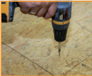
**1** Lose bzw. federnde Holzuntergründe müssen zunächst nachverschraubt werden. Darüber hinaus ist die Ebenflächigkeit des Untergrunds mittels Richtlatte zu beurteilen.
