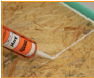
**2** Bei notwendigen Spachtelarbeiten, die Fugen mit Racofix® Acryl verschließen, sodass die Fließspachtelmasse nicht in die Fugen eindringen kann. Im Übergangsbereich von Wand- und Bodenflächen einen Randdämmstreifen stellen.
