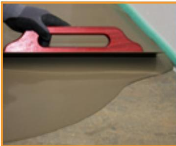
**4** Bei Unebenheiten im Untergrund, Racofix® RF 7-Fließspachtel mit der auf dem Gebinde angegebenen Menge Wasser anrühren (auf genaue Wasserdosierung achten), ausgießen und mittels Glättkelle verteilen.
