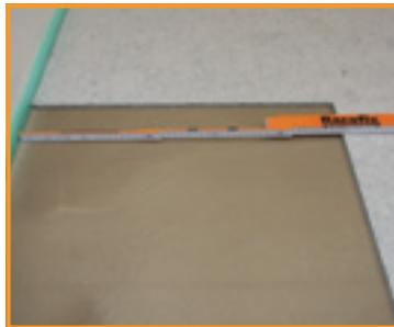
**5** Den Raum vor der Verlegung von Racofix® Entkopplungs- und Dämmplatte zunächst genau vermessen. Racofix® Entkopplungs- und Dämmplatte lose nebeneinander auslegen. Stöße nebeneinander liegender Reihen versetzt verlegen.
