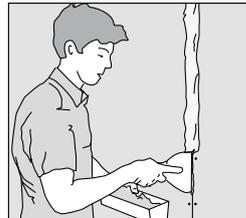
**5.** Danach die Spachtelmasse von oben nach unten scharf abziehen, um eine plane Fuge zu erzielen. Ansätze und Grate werden im nächsten Arbeitsgang abgestoßen. Bei HRK-Kanten sind ggf. zwei Spachtelgänge mit *Knauf Uniflott* notwendig.
