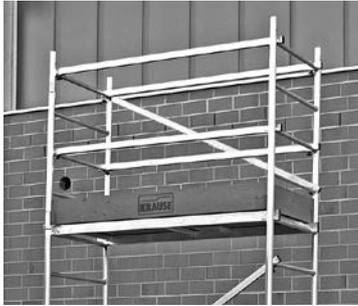
Şekilde hazır monte edilmiş kenar koruma donanımı görülmektedir.
