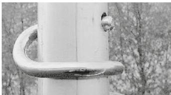
Все стыковочные соединения скреплять замкательями.
