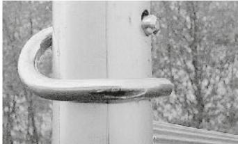
Alle Steckverbindungen müssen mit Fallsteckern gesichert werden.
