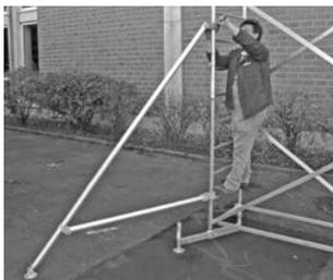
Na zdjęciu sposób zamontowania podpory.
