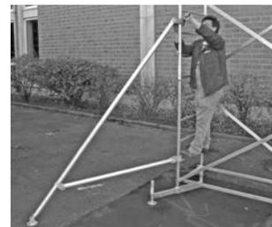
På billedet ses hvordan stabiliseringssættene til væg anbringes.
