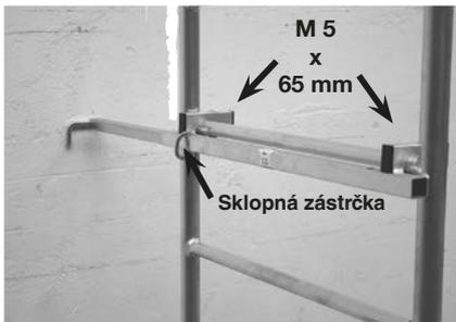
Namontujte stabilizačnú súpravu na priečku pod najvrchnejšou podlahou plošiny.
