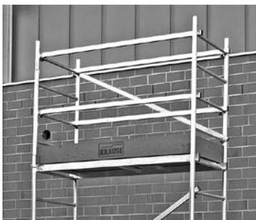
Na zdjęciu zmontowana ochrona boczna.
