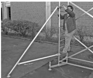
Na zdjęciu sposób zamontowania podpory.
