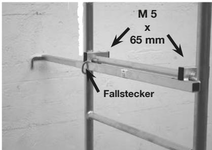
Montieren Sie das Stabilisierungsset an der Sprosse unterhalb der obersten Belagbühne.
