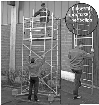
Fiksering med sikkerhetsclips
