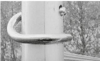
Alla stickförbindelser måste vara säkrade med låsanordningar.
