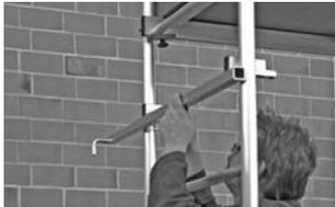
Op de foto is het aanbrengen van de stabilisatiesets te zien.
