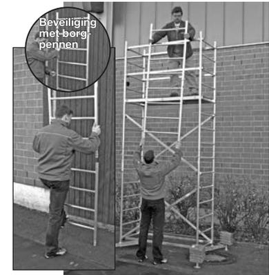
Basisplatform met eerste en tweede slag
