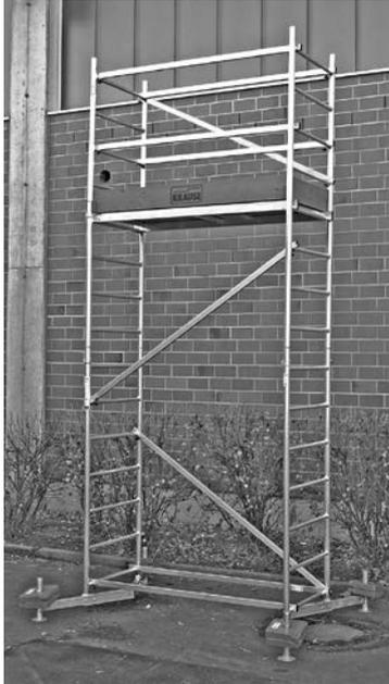
Kuvassa näytetään valmiiksi asennetut telineet yhdellä lisäkerroksella ja 8 painolastipuntilla
