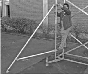
Şekilde destek kollarının donatılması gösterilmektedir.
