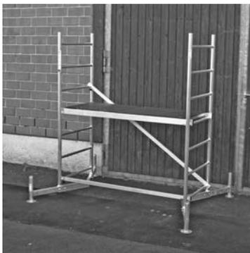
Na zdjęciu gotowa, zmontowana podstawa rusztowania.
