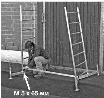
Базовая конструкция с первой надстройкой
