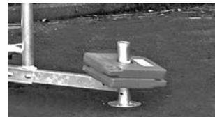
Slika prikazuje nameščanje opornika.
