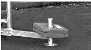
Bilden visar pålagd ballast på traversen.
