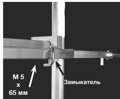
навесить якорную трубу в якорный рым-болт закреплённый на стене. Закрепить якорную крепёжную трубу к перекладине под верхним помостом. Застраховать страховочными зажимами. Застопорить подвижную часть трубы замыкателем
