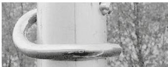
Tous les raccords à emboîtement doivent être sécurisés par des crochets.
