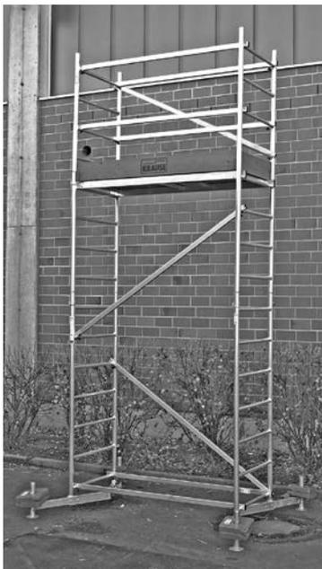
På billedet ses det færdigt monterede stillads med første tilbygning og 8 ballastvægte
