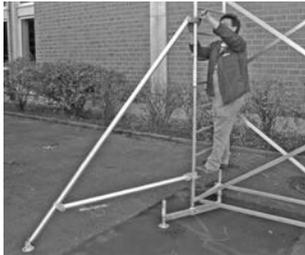
La ilustración muestra la instalación de salientes.
