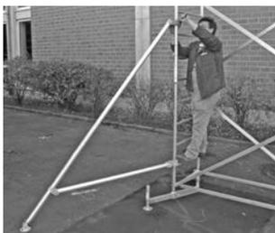
La ilustración muestra la instalación de salientes.
