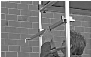
La ilustración muestra la instalación de distanciadores a la pared.
