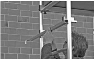
Obrázok ukazuje upevnenie stabilizačnej súpravy.
