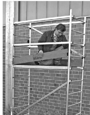
På billedet ses den færdigt monterede sidebeskyttelse
