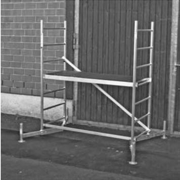
Şekilde montajı tamamlanmış alt iskele görülmektedir.
