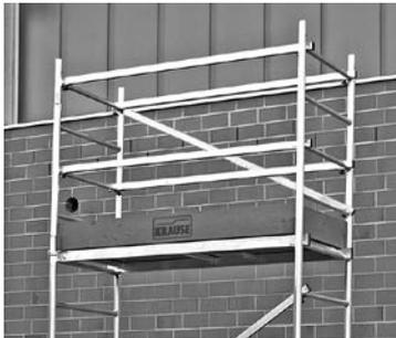
Die Abbildung zeigt den fertig montierten Seitenschutz.
