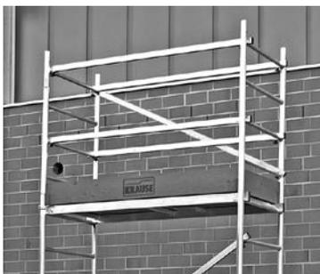
La ilustración muestra la protección lateral montada terminada.
