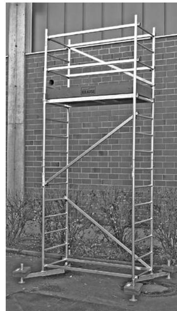
Базовая конструкция с первой надстройкой
