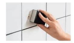
3. Alte Bohrlöcher mit Alpina Bad & Küche 2in1 Fliesen-Spachtel verschließen. Nach dem Trocknen mit einem Schleifpad beischleifen und Schleifstaub entfernen. Die Flächen müssen absolut frei von Staub, Fett, Kalk und Reinigungsmittelrückständen sein.
