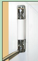
1. Montieren Sie den Fenstergriff auf dem Flügel und schrauben diesen fest. Anschließend hängen Sie den Flügel aus, indem Sie den Scherenlagerdorn herausziehen, bis die Feder einrastet. Nun den Flügel öffnen und herausheben.
