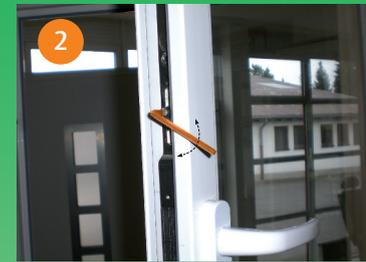
Flügelndruck regulieren mit 4 mm Inbusschlüssel
