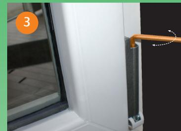
Flügel auf der Bandseite anheben und senken mit 4 mm Inbusschlüssel
