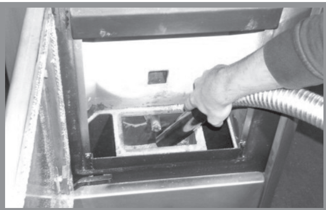
Abb. 12f: Reinigung Brennraumbehälter
