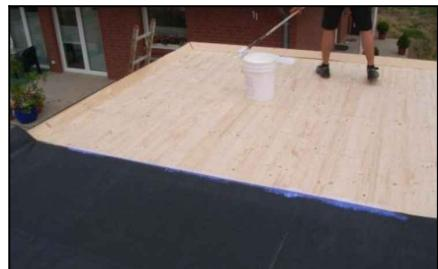
Sla ca. 50% van de folie terug (b.v. in één stuk of in grote lussen) en rol vervolgens de lijm op waterbasis met de verfroller gelijkmatig uit op de ondergrond. op het substraat.
