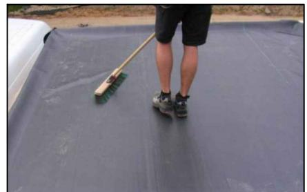
Přetáhněte přeloženou zadní fólii na část, která byla natřena lepidlem, a uhláďte fólii smetáčkem od středu střechy. a začněte od středu střechy a uhláďte fólii smetáčkem tak, abyste odstranili záhyby. jsou odstraněny. Tyto kroky zopakujte se zbývající fólií.
