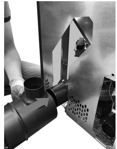
Fig. 42 - Das konzentrische Rohr anschließen
