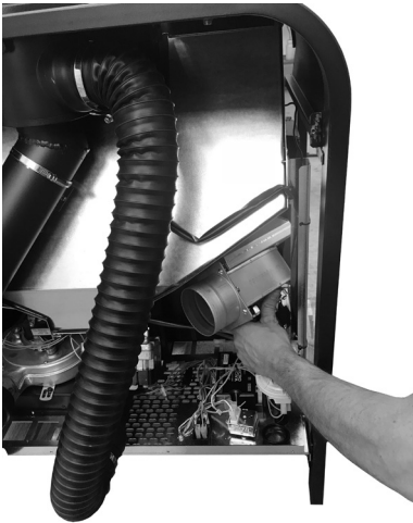
Fig. 36 - Das Gehäuse + Ventilator am Ofen fixieren.
