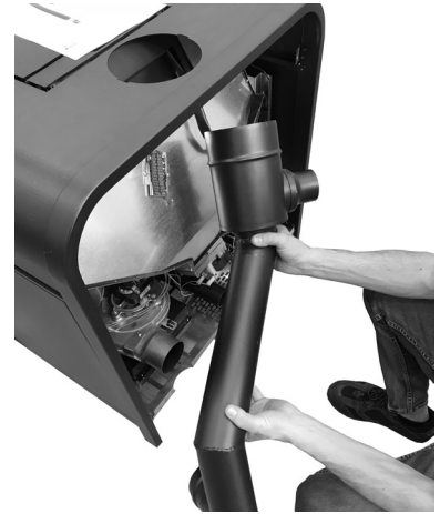
Fig. 48 - Rauchgasauslassleitung + konzentrisches Rohr positionieren
