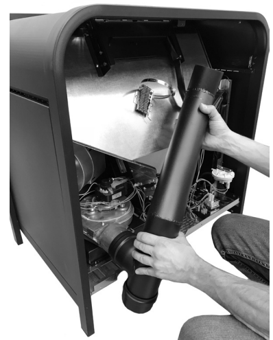
Fig. 25 - Rauchgasauslassleitung positionieren
