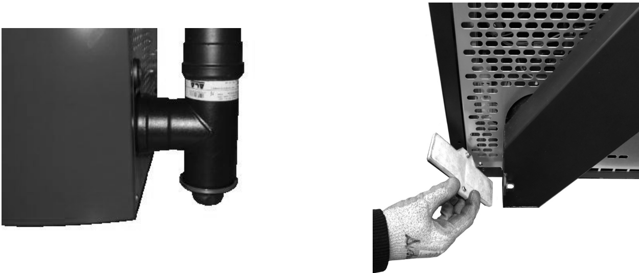
Fig. 74 - Reinigung des Rauchgaskanals
