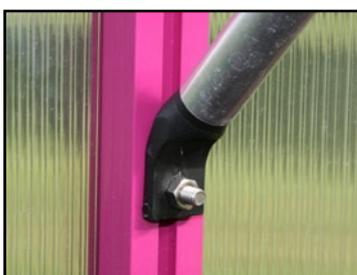
Wanne an den Gewächshausprossen verschrauben. Hierzu die Streben (Pos. 3) an den Sprossen anschrauben. Verwenden Sie an den Randsprossen bitte Hammerkopfschrauben M6 x 16 (S15).
