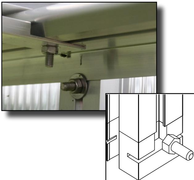
Im Bereich des Kunststoffgleiters zwei Schrauben M6 x 16 (S5) einziehen.
