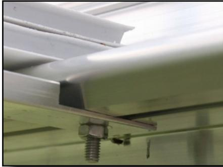
Befestigen Sie den Abstandshalter (Pos. 4) mit den Sechskantschrauben M6 x 16 (S5) am Längsprofil (Pos. 1).
