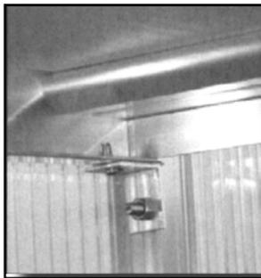
Montieren Sie den Winkel mit einer Hammerkopfschraube M6 x 16 (S15) an die Randsprosse. Legen Sie dann die Pflanzwanne auf dem Winkel auf und verbinden beides mit einer Bohrschraube 3,5 x 13 (S22) miteinander.
