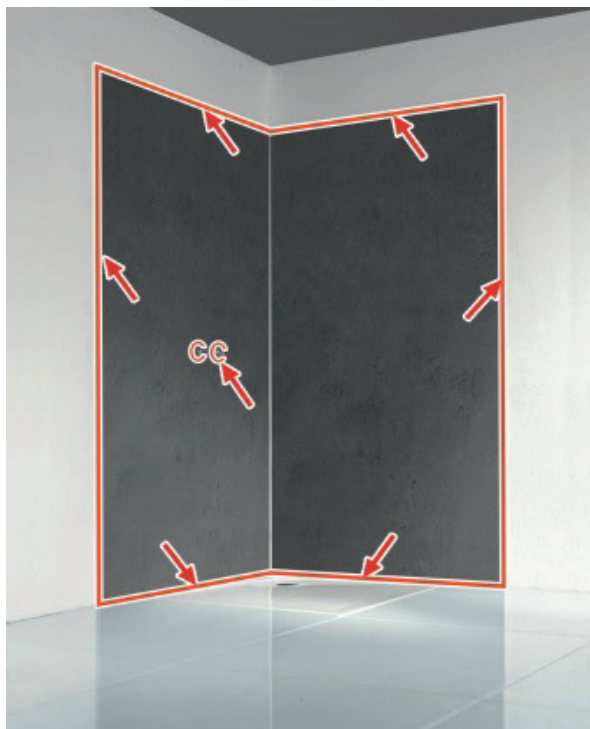
3.18 Designplatten rundum zur Wand hin mit essigsäurefrei vernetzendem Naturstein-Silikon abdichten.
