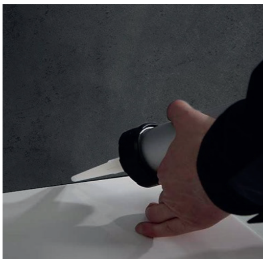
3.19 Bodenbereich mit essigsäurefrei vernetzendem Naturstein-Silikon abdichten. Das Silikon 24h aushärten lassen.
