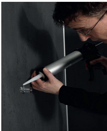
3.17 Durchführungen mit essigsäurefrei vernetzendem Naturstein-Silikon abdichten.
