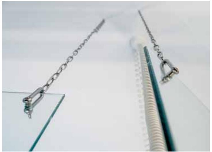
**Ganz sicher:** Mit Schäkkel und Gliederkette wird das gebohrte Glas unter die Decke montiert.
