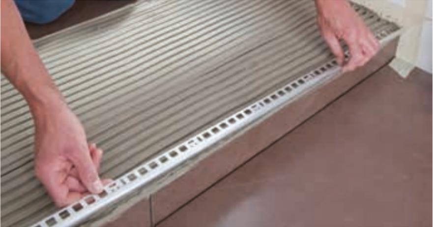
1. Achten Sie bei der Wahl des passenden Profils darauf, dass die Profilhöhe gleich hoch ist wie die Fliesenstärke.
