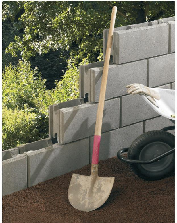
Schalungssteine lassen sich gut und schnell verarbeiten und sind neben dem Bau von Mauern auch zur Herstellung von Streifenfundamenten, Einfassungen sowie Stütz-, Schallschutz- oder Kellerwänden (je nach Befüllung) geeignet. Durchgehende Öffnungen in senkrechter und waagrechter Richtung ermöglichen das einfache Einbringen von Beton und Bewehrungsseisen.
