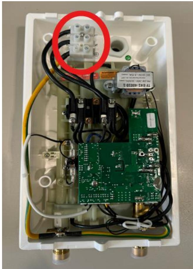
4. Schließen Sie das separat erworbene Anschlusskabel entsprechend der Beschriftung innerhalb des Anschlussblocks an und drehen die Schrauben fest an:
