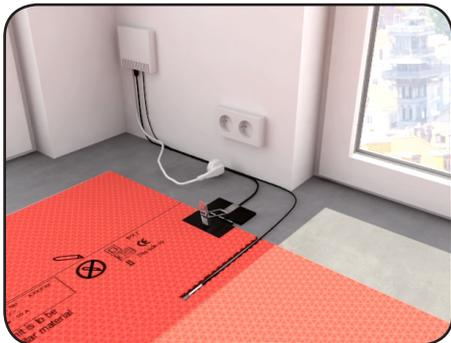
Kann der Sensor nicht im Schlitz platziert werden, platzieren Sie ihn auf der Heizmatte. Stellen Sie sicher, dass das Ende des Sensors zwischen zwei Heizkabeln liegt. Befestigen Sie den Sensor mit dem beiliegenden Aluminiumband an der Heizmatte.
