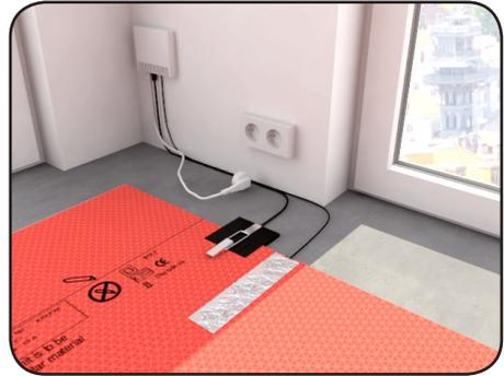
Stellen Sie sicher, dass das Ausgangskabel nicht übermäßig gedrückt oder gebogen wird. Der *minimale Biegedurchmesser beträgt 5 cm*.
